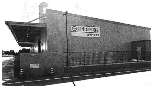
九十九里倉庫の外観
